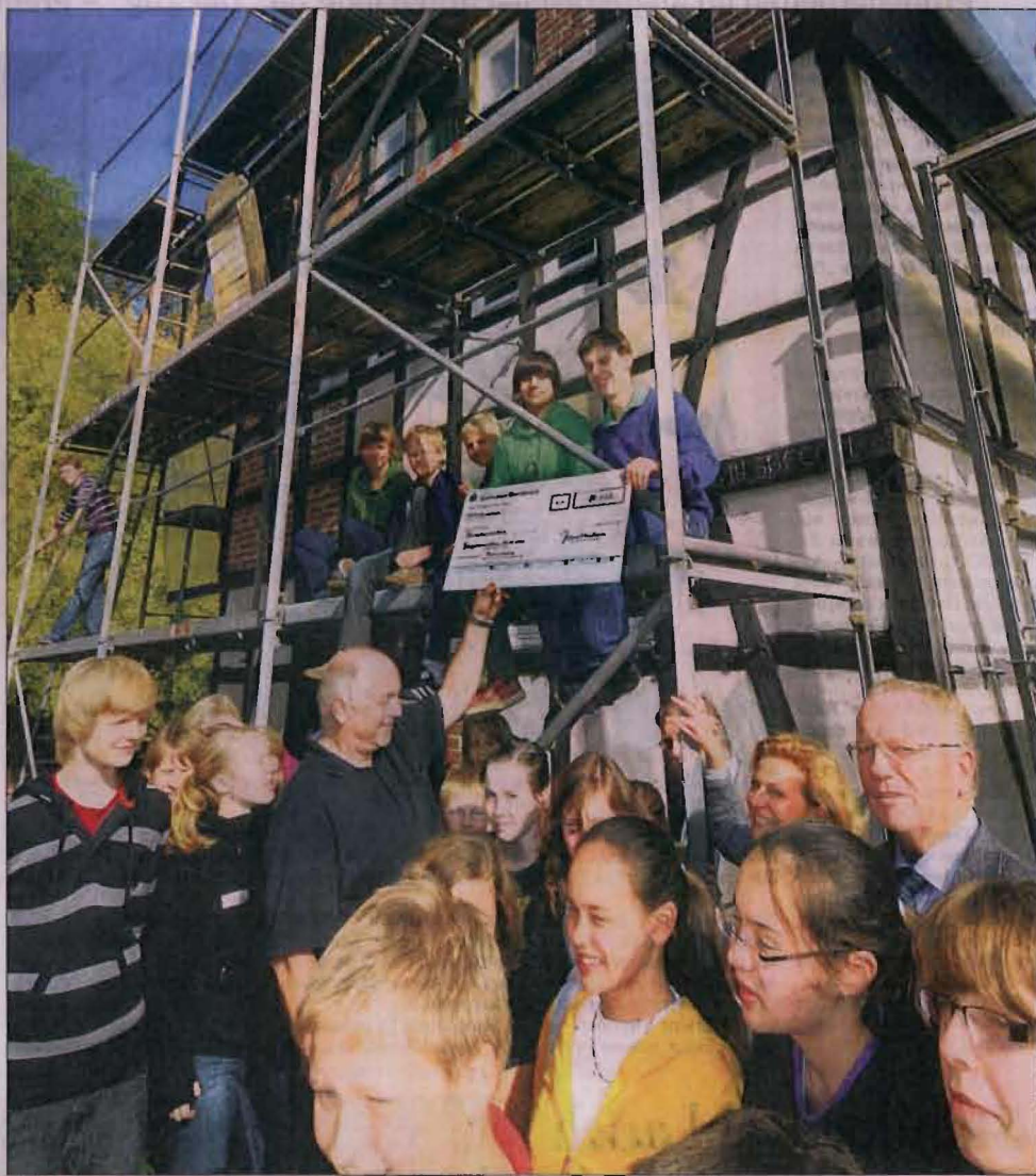
Die Sanierung des Domchorkottens soll voraussichtlich im kommenden Jahr abgeschlossen werden.
